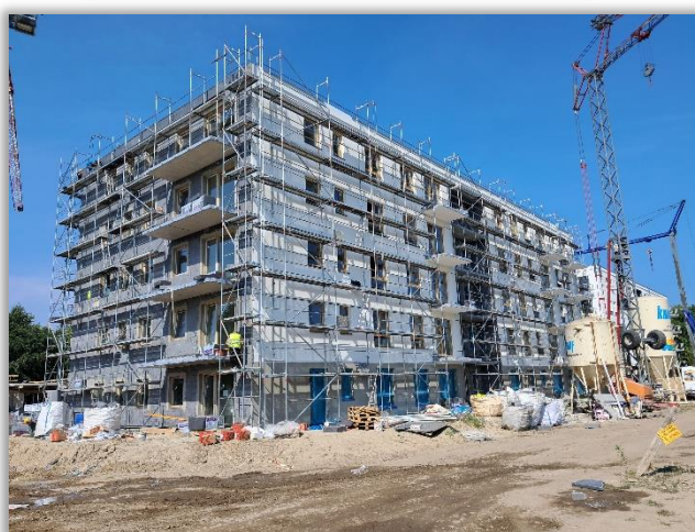
Zdjęcia z budowy II etapu „art.TEO” – budynek D
