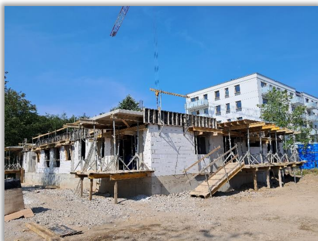
Zdjęcia z budowy III etapu „art.TEO” – budynek E
