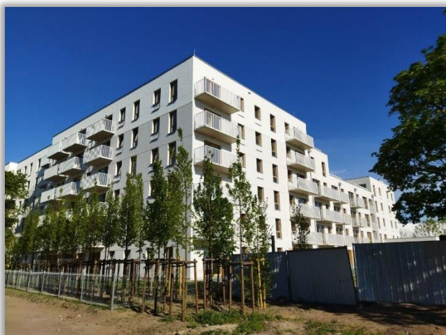
„Junique IA” – zdjęcia z budowy
