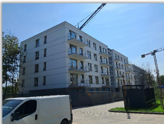
Zdjęcia z budowy II etapu „art.TEO” – budynek B
