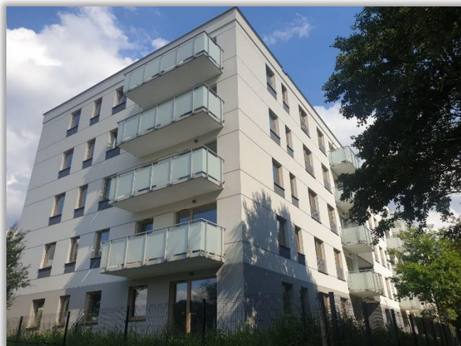
Zdjęcia wybudowanego etapu I
