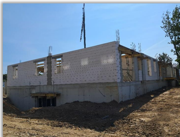
Zdjęcia z budowy III etapu „art.TEO” – budynek F
